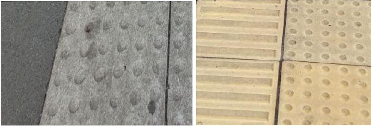
*Рис. Приклади спеціальних тактильних смуг*
