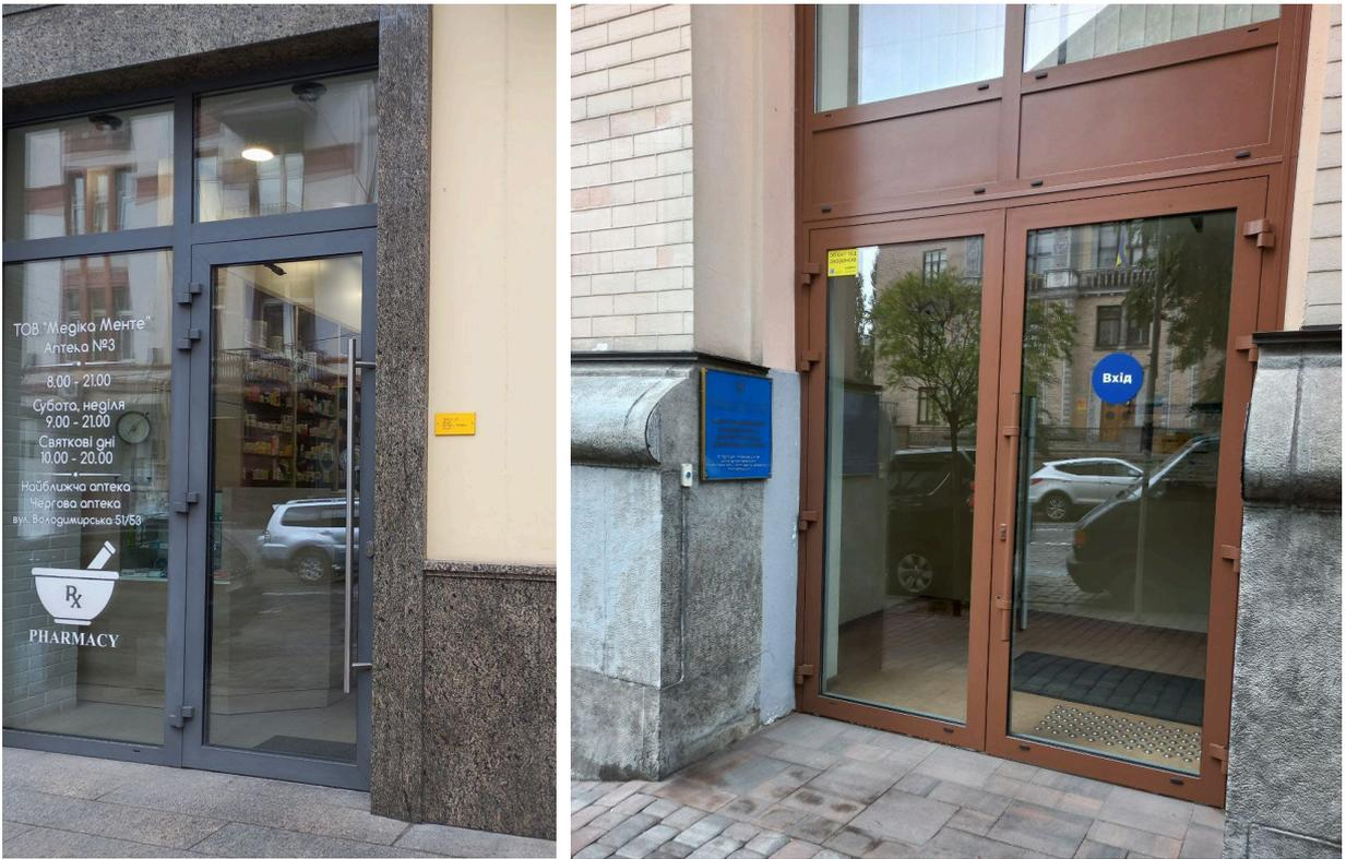
Фото. Приклади рішень входних груп з дверною ручкою-скобою та інформаційними табличками шрифтом Брайля
