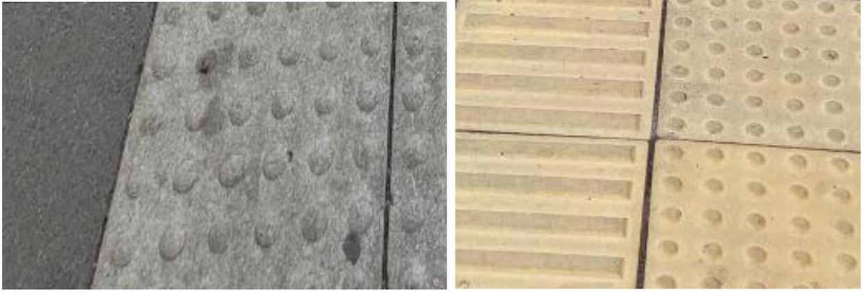
*Рис. Приклади спеціальних тактильних смуг*
