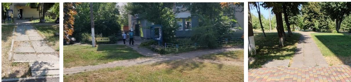
*Фото. Ділянки з незадовільним станом покриття пішохідних шляхів*
