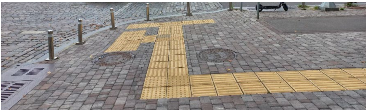
Фото. Приклад некоректного застосування тактильної смуги.
