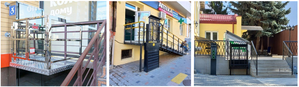
Фото. Приклади влаштування підйомників
